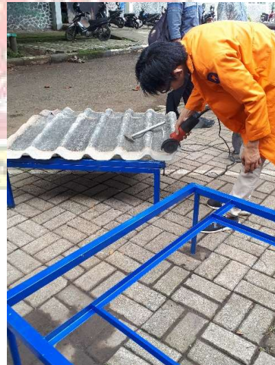
Pemasangan atap pada rangka
