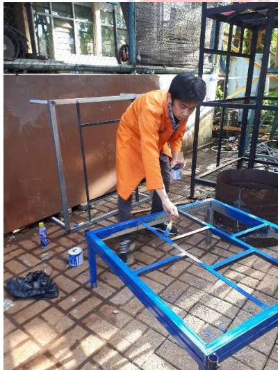
Pengecatan rangka panel surya dan atap
