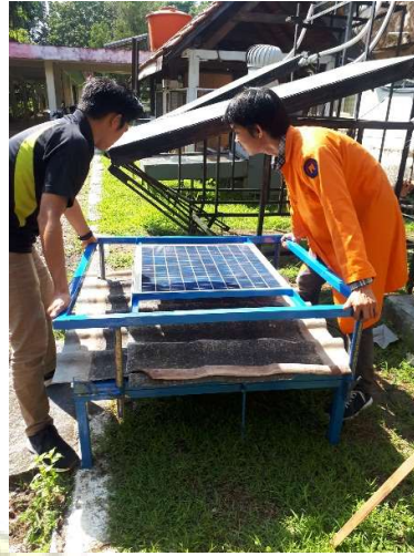
Pemasangan rangka panel surya
