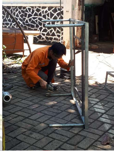
Perakitan rangka penyangga panel surya
