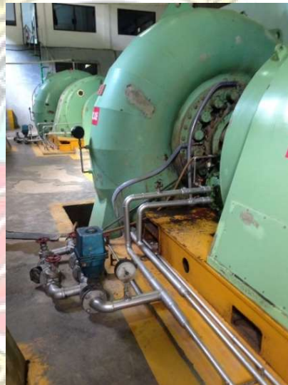
Gambar 2.5 Turbin Air pada PLTM Malea
