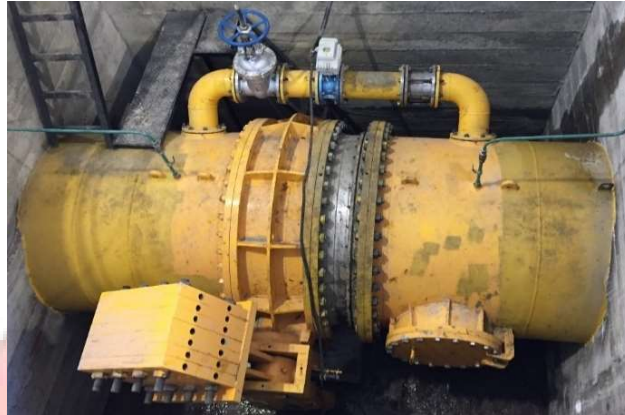
Gambar 2.8 Main Inlet Valve pada PLTM Malea
