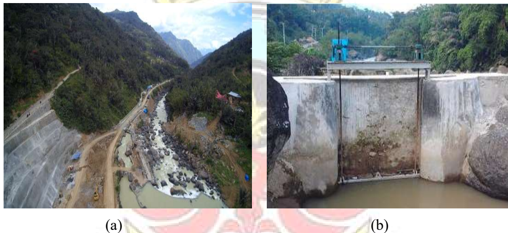
Gambar 2.1 (a) Weir , (b) Intake pada PLTM Malea
