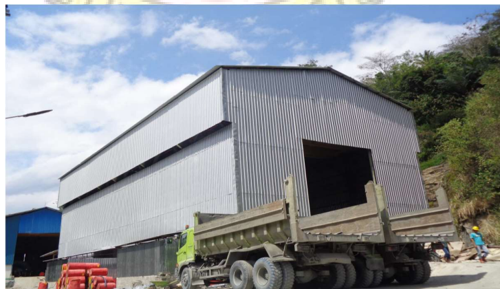
Gambar 2.9 Power House pada PLTM Malea
