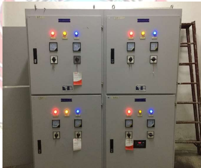
Gambar 2.13 Gardu Hubung pada PLTM Malea
