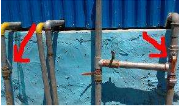
7. tutup valve yang menuju ke radial guide bearing dan radial thrust bearing
