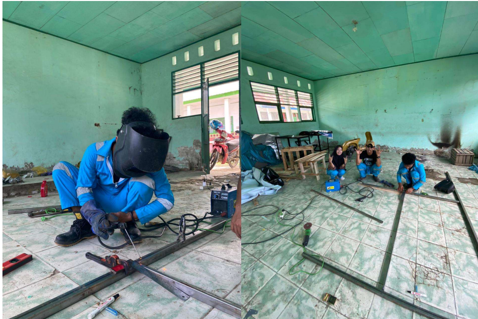
Gambar L4 Proses penyambungan besi menggunakan las listrik
