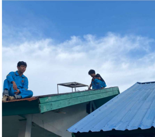
Gambar L4 Proses pemasangan panel surya pada atap Gedung
