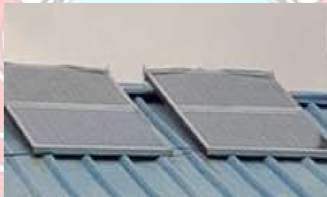
Gambar 4.1 Hasil Perancangan dudukan panel surya
