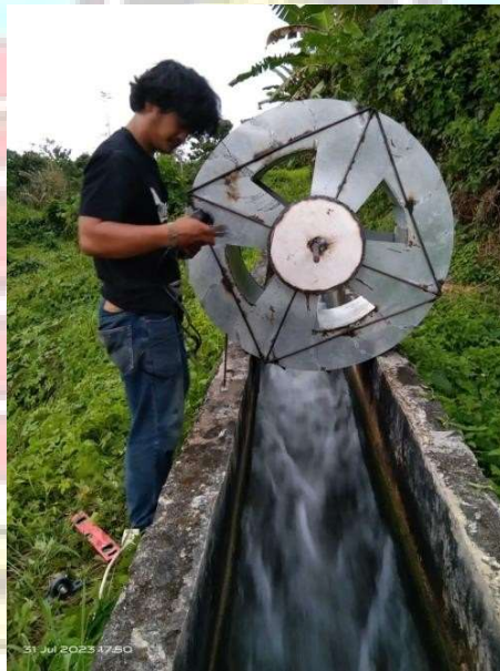
Gambar 5.7 Pemasangan Kincir Pada Saluran Irigasi
