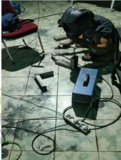
Gambar 5.6 Pembuatan Dudukan Generator
