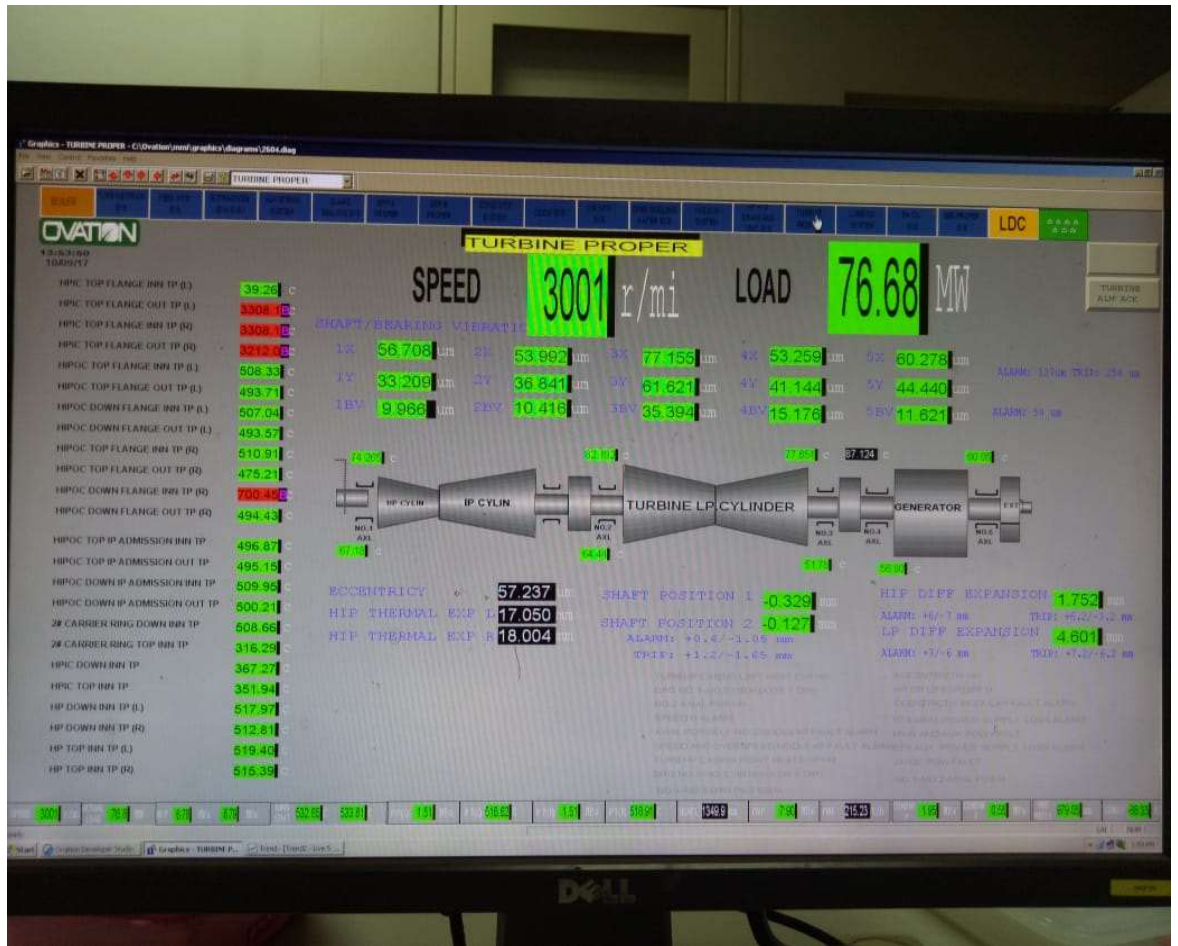
Gambar Turbine Proper di PLTU Bosowa Energi Jeneponto
