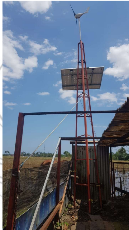
Gambar 4.1 Konstruksi Pembangkit Sistem Hybrid PLTS-PLTB
