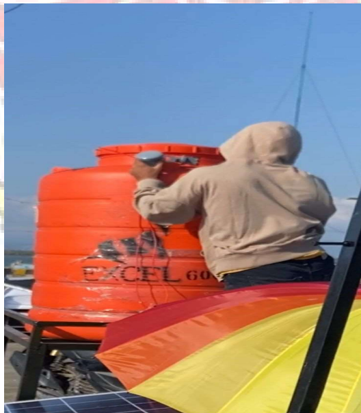
Pemasangan Pelampung Otomatis
