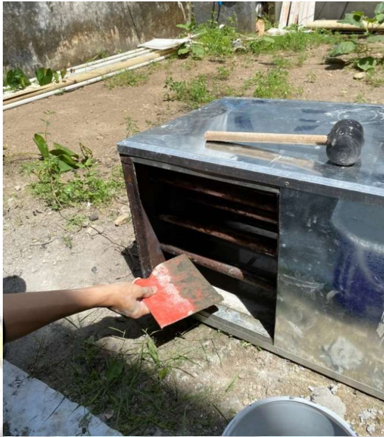
Pemasangan Keramik pada Ruang Pembakaran
