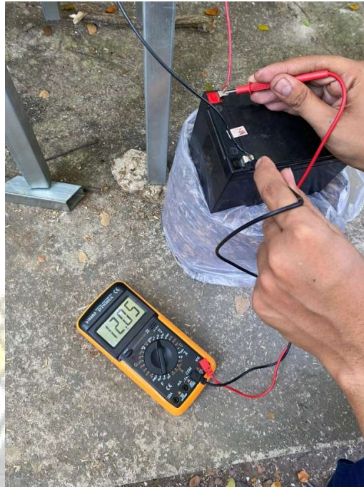
Pengukuran Tegangan Aki Menggunakan Multimeter Digital
