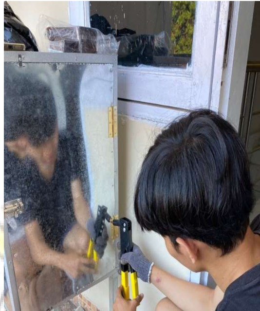
Pemasangan Engsel dan Grendel Pintu Ruang Pengering
