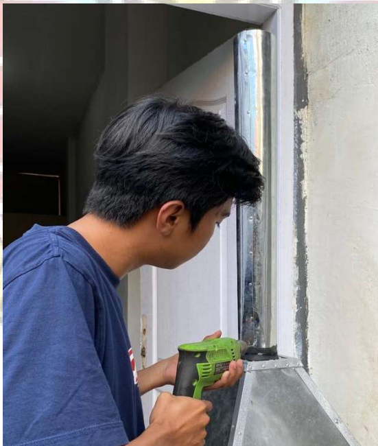
Pemasangan Seng Plat pada Cerobong
