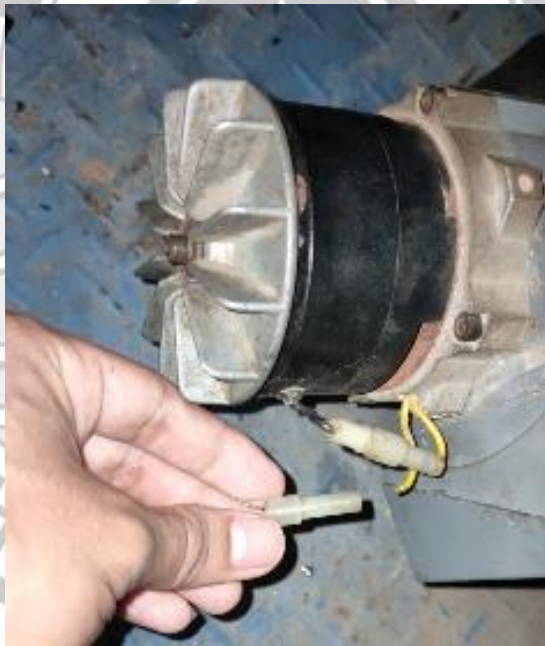
Gambar 4.3 Kabel penghubung motor ke elektromagnetik brake Yang putus.
