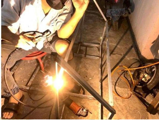
Gambar proses pengelasan untuk pemasangan bearing
