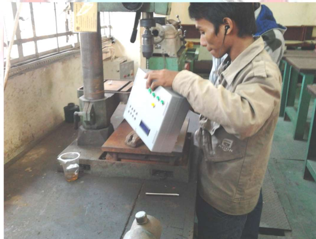
Proses Pemasangan kotak panel
