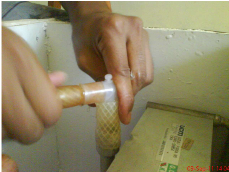
Gambar E.9. Proses pemasangan selang pada Heat Exchanger
