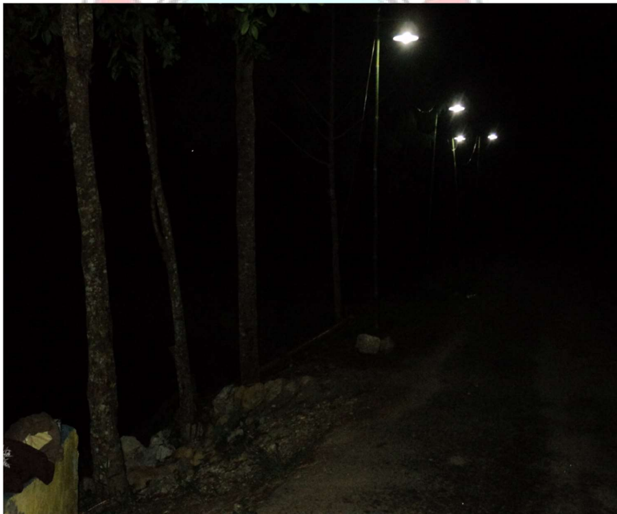
Lokasi setelah lampu dinyalakan
