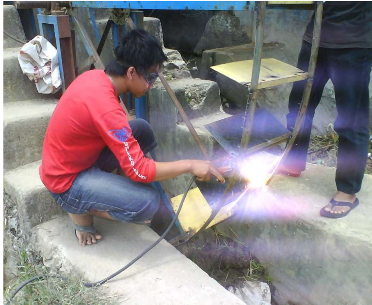
Foto perbaikan/pengelasan kincir
