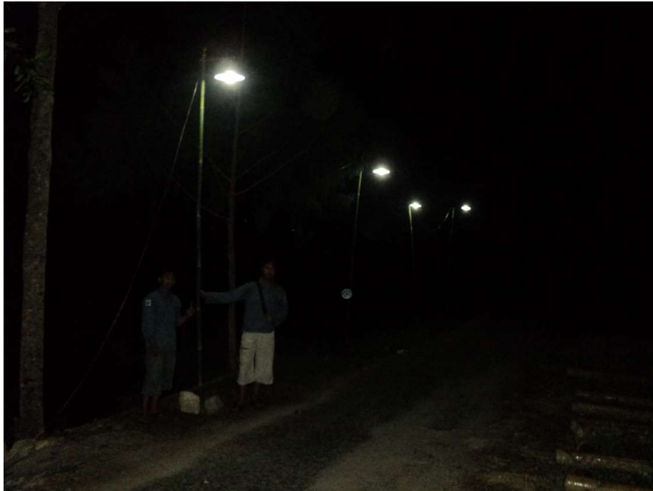
Foto setelah pemasangan dan pengetesan lampu
