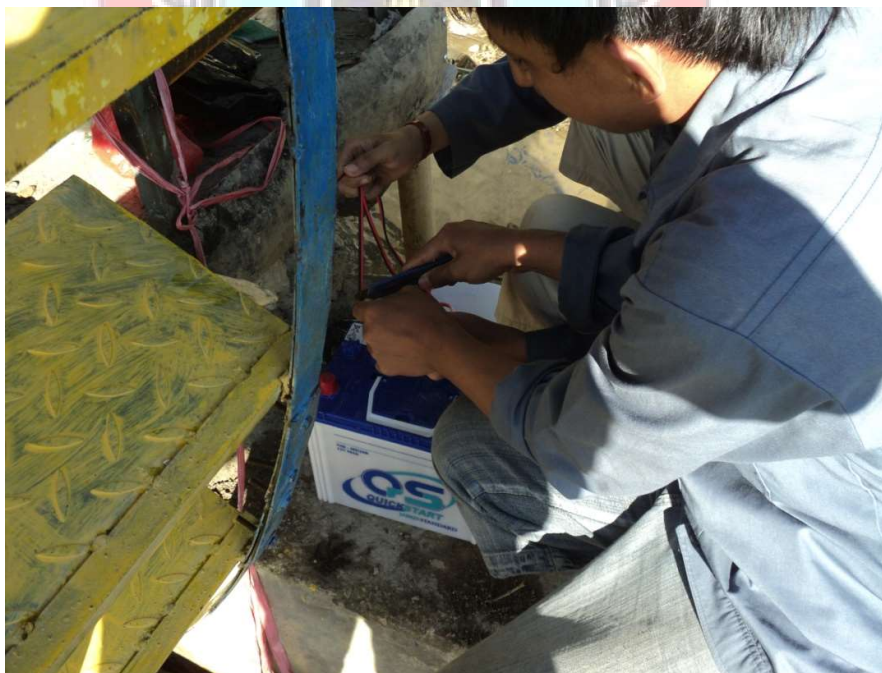
Pemasangan accu dan inverter
