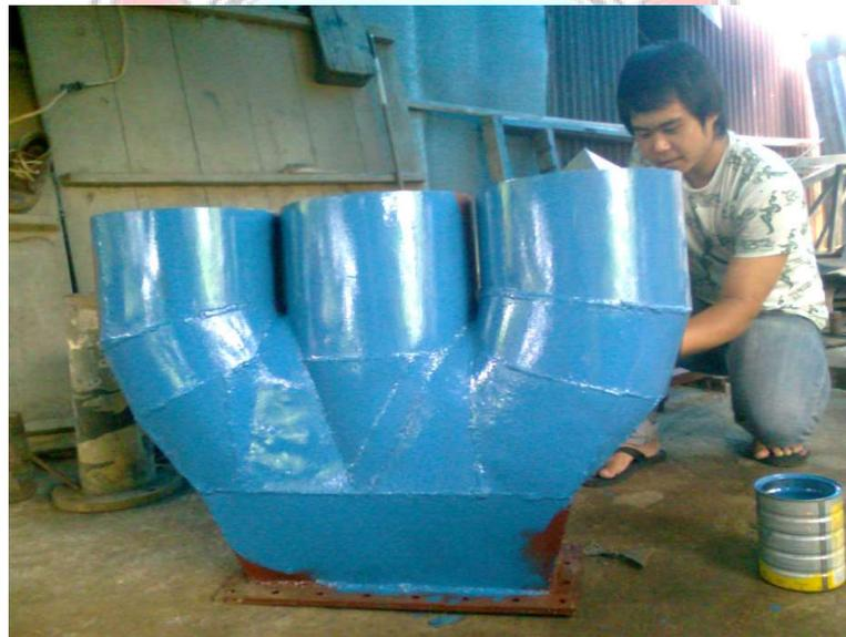
**Gambar 12. Proses pengecatan sambungan pipa (*Adaptor*)**
