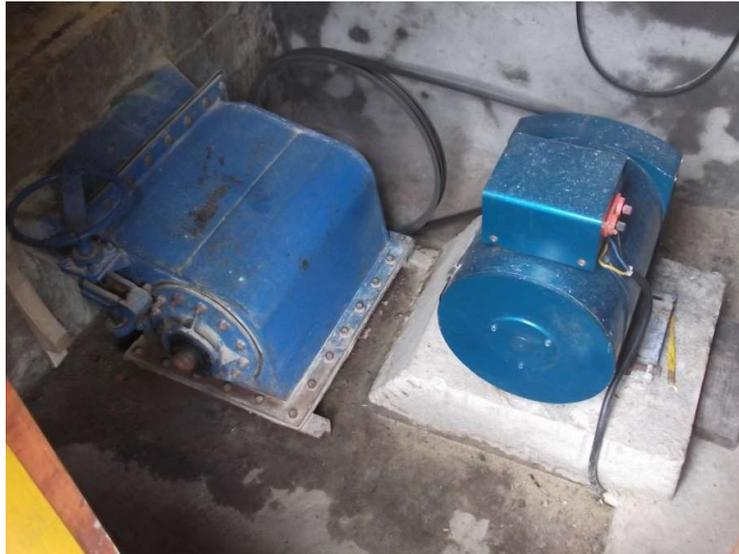
**Gambar 19. Pembangkit listrik tenaga Mikrohidro (PLTMH)**
