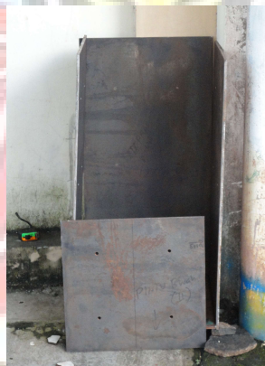
Gambar 3.2 Penyusunan plat kotak kemasan sebelum dilas
