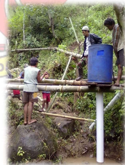
Proses Pemasangan Saluran
