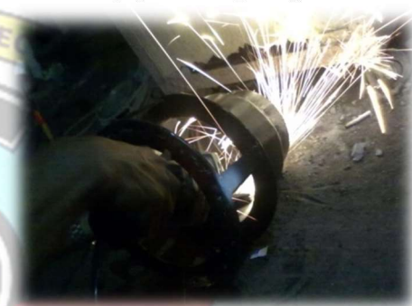
Proses Gerinda dan finishing Rumah Turbin
