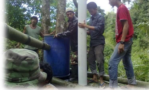
Proses Perakitan saluran keluaran turbin.
