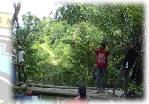
Proses Pemasangan Instalasi pengujian dalam kondisi berbeban
