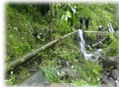
Aliran air dalam medium bambu sebagai Pipa Penstock menuju ke wadah picohydro
