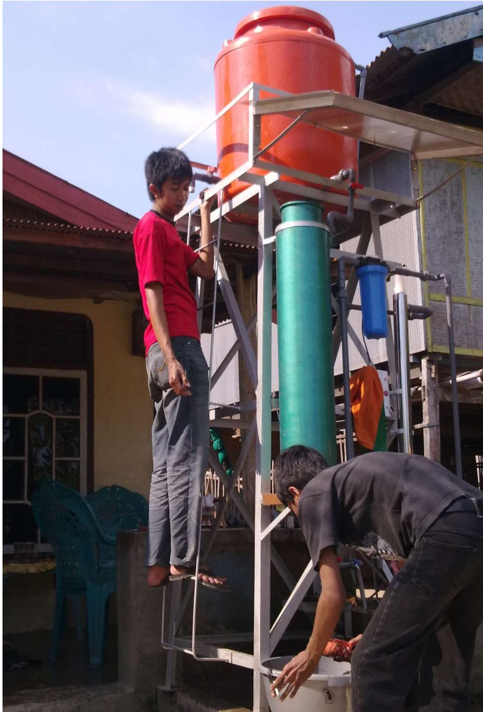
**Lampiran 12. Proses Pemasangan Kembali Karbon Aktif dan Arang Aktif Setelah Penyetelan pada Alat Penjernih Air dengan Proses Filtrasi**
