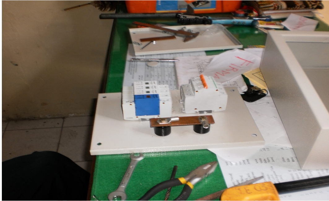
Lampiran 25. Tata Letak Komponen Penangkal Petir Internal Sebelum Dihubungkan
