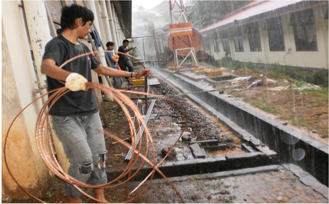
Lampiran 9. Proses penyambungan Penghantar Pentanahan
