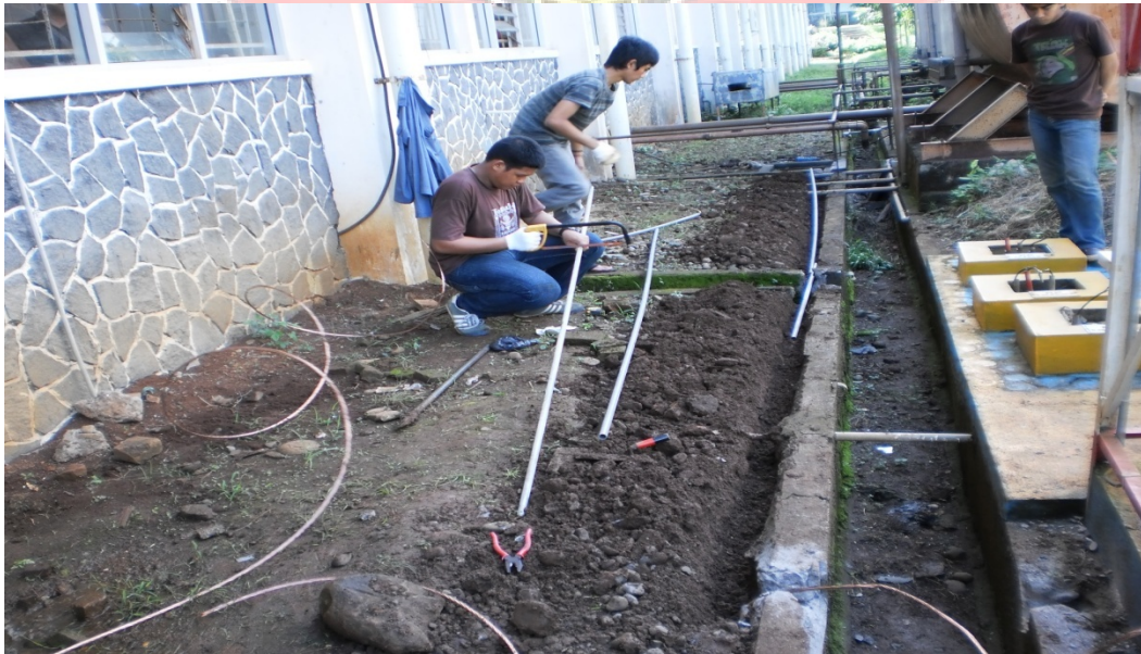
Lampiran 10. Proses Pemotongan Pipa untuk penghantar
