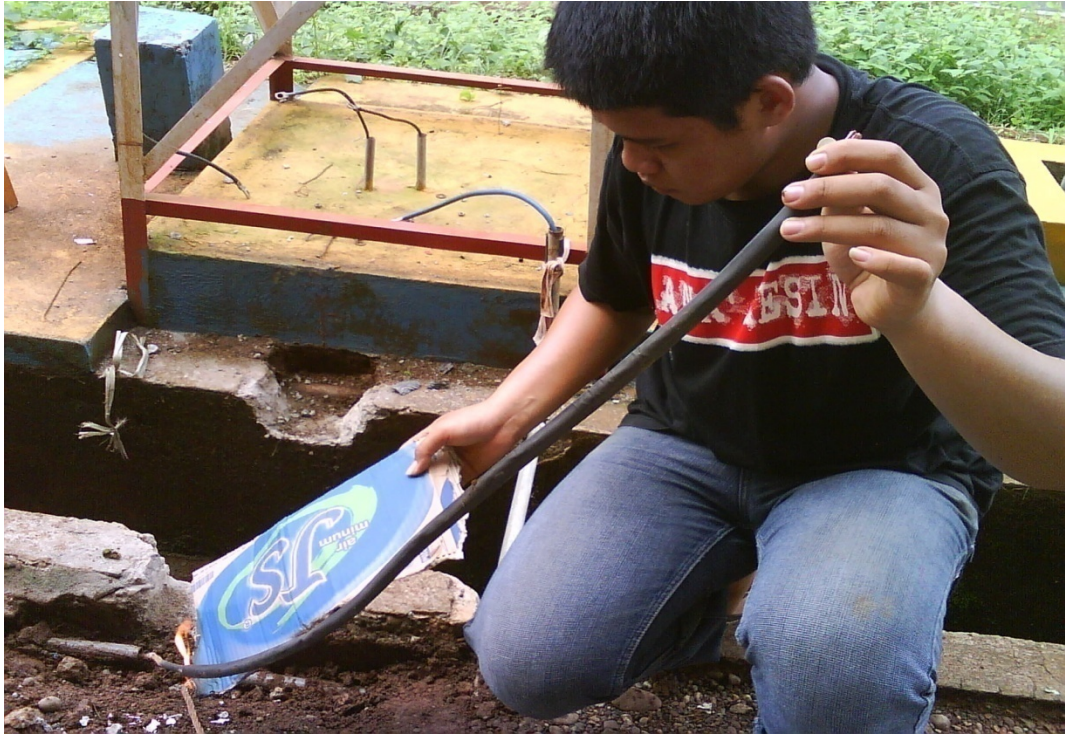
Lampiran 17 Proses Pemasangan Isolasi Pada Kabel Tembaga
