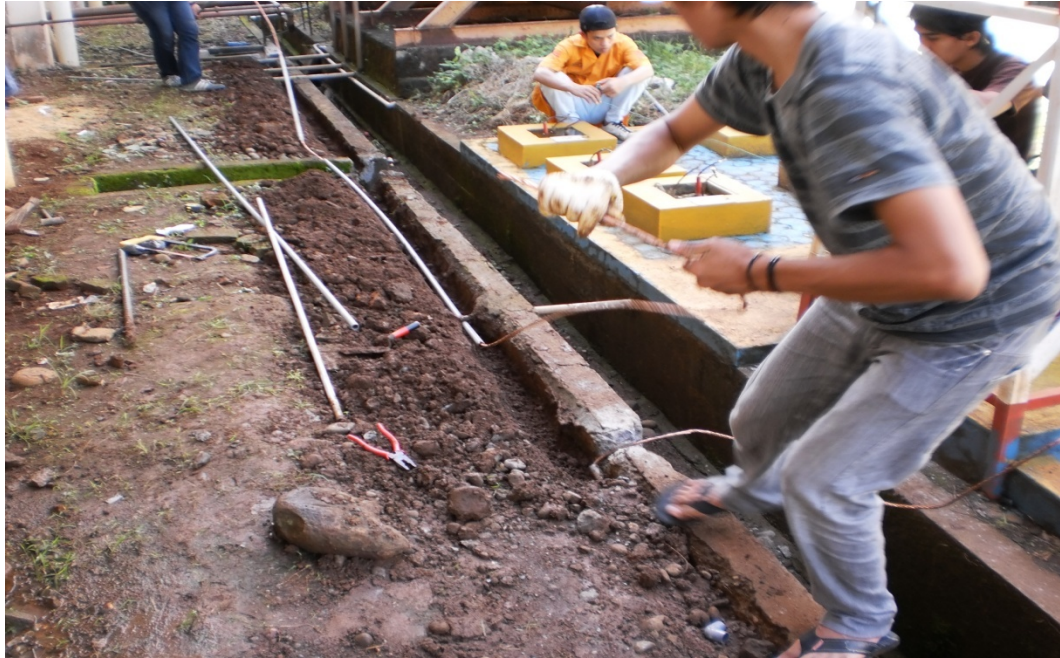
Lampiran 11. Kabel penghantar dirapikan sebelum ditanam ditanah
