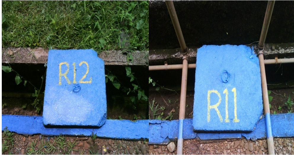
Lampiran 43. Gambar penutup elektroda batang yang digunakan sebagai elektroda tambahan
