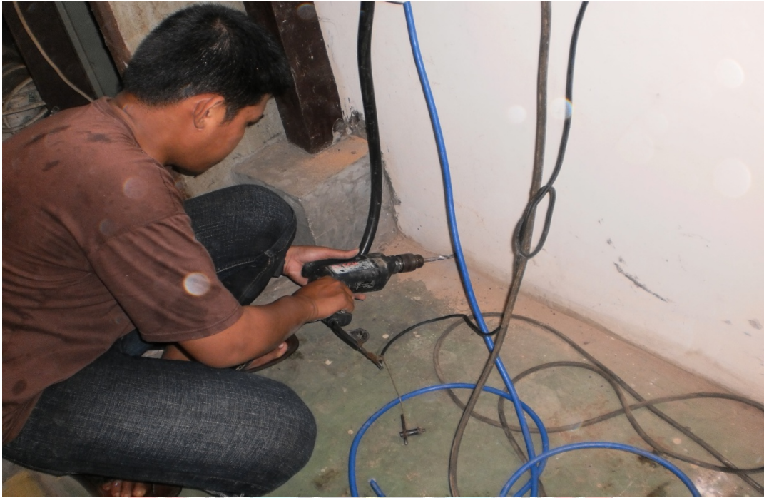
Lampiran 27. Pengoboran untu membuat saluran kebel Pentanahan
