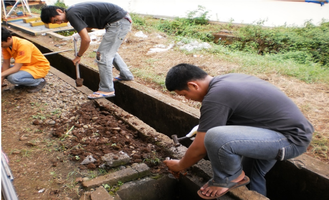
Lampiran 7. Pembuatan Saluran Penghantar untuk Penangkal Petir Eksternal
