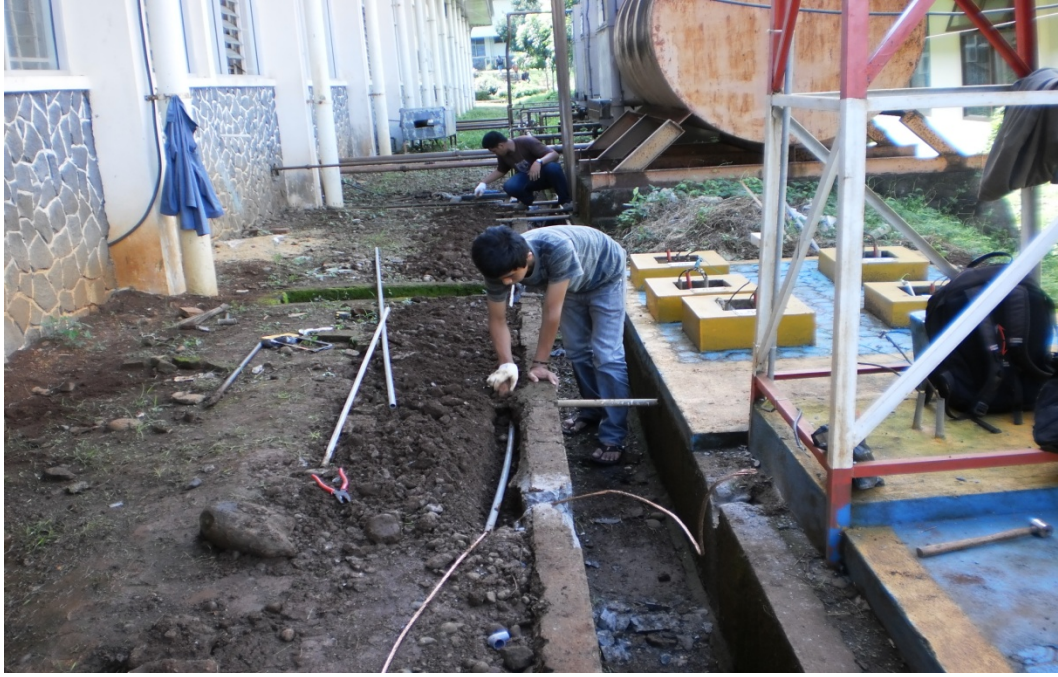
Lampiran 14. Proses penimbungan penghantar Pentanahan kedalam Tanah
