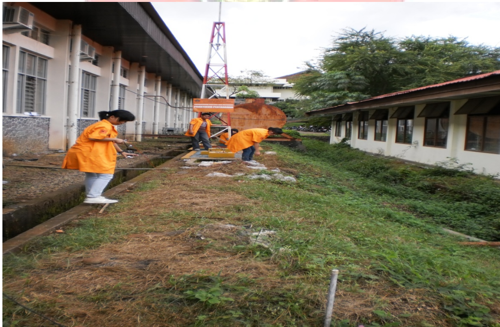
Lampiran 34. Proses pemasangan pasak sebagai alat bantu pengukuran
