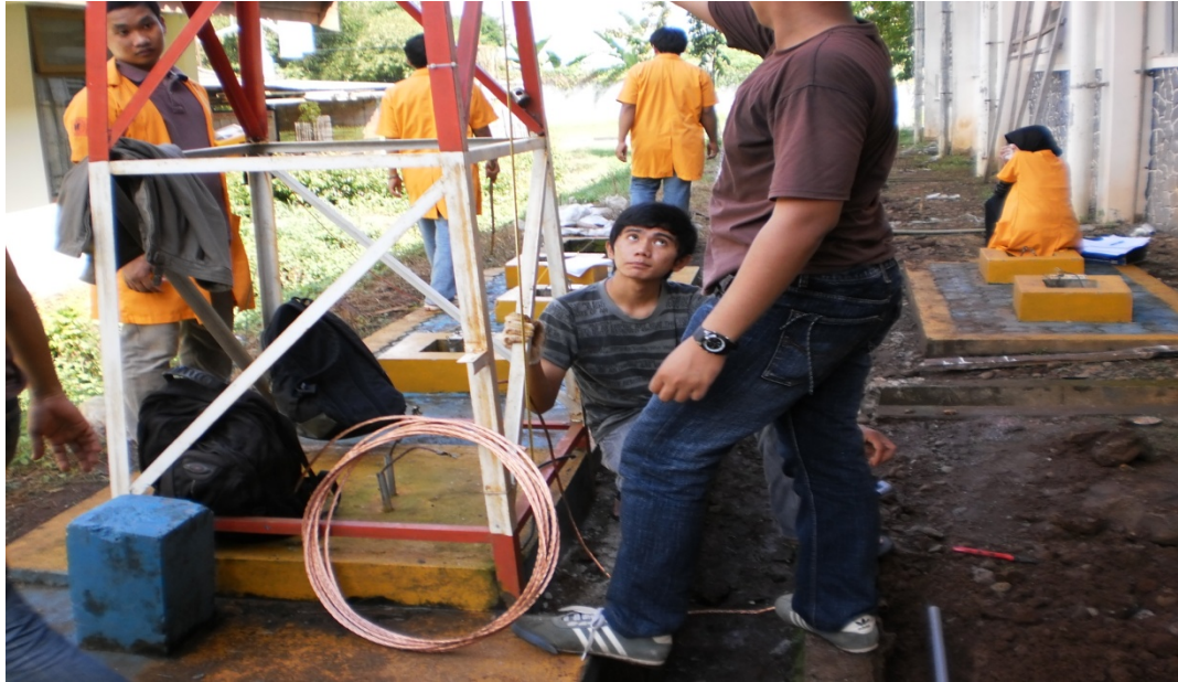
Lampiran 21. Pengukuran untuk pemasangan Box Panel Laightning Counter
