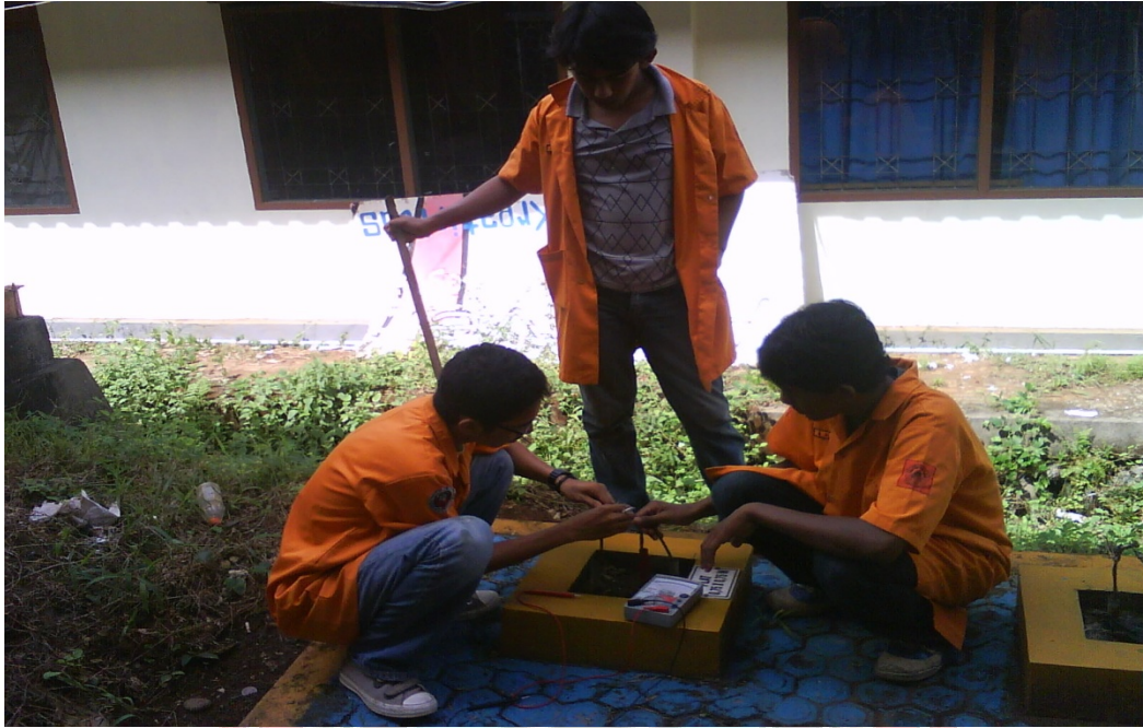
Lampiran 33. Proses penyambungan elektroda yang berbeda ukuran (paralel)
