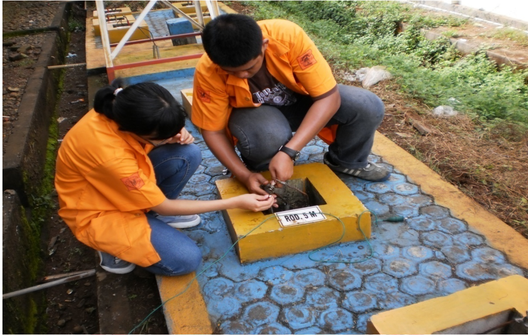
Lampiran 35. Pemasangan titik Earth (E) pada elektroda dari alat ukur.
