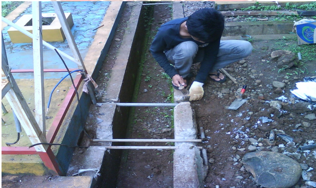
Lampiran 16. Proses Pembuatan Saluran Penghantar Untuk Penangkal Petir Eksternal
