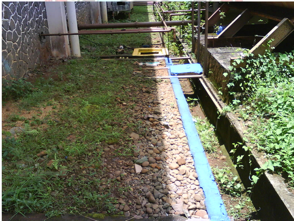
Lampiran 44. Gambar jalur penghantar elektroda tambahan yang dihubungkan secara paralel.
