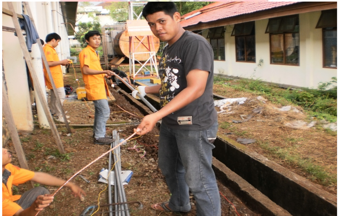
Lampiran 8. Proses Pemasukkan Penghantar Tembaga kedalam Pipa
