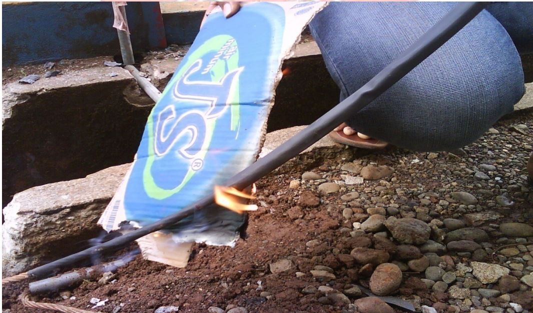
Lampiran 18. Proses Pemasangan Isolasi Pada Kabel Tembaga
