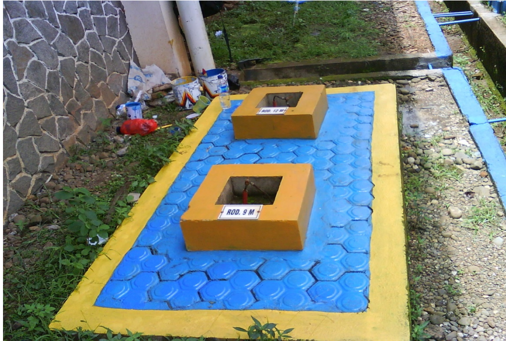
Lampiran 39. Gambar elektroda batang dengan kedalaman 12 meter dan 9 meter
