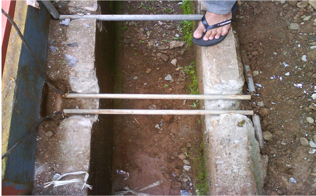
Lampiran 19. Gambar penghantar penangkal petir eksternal
