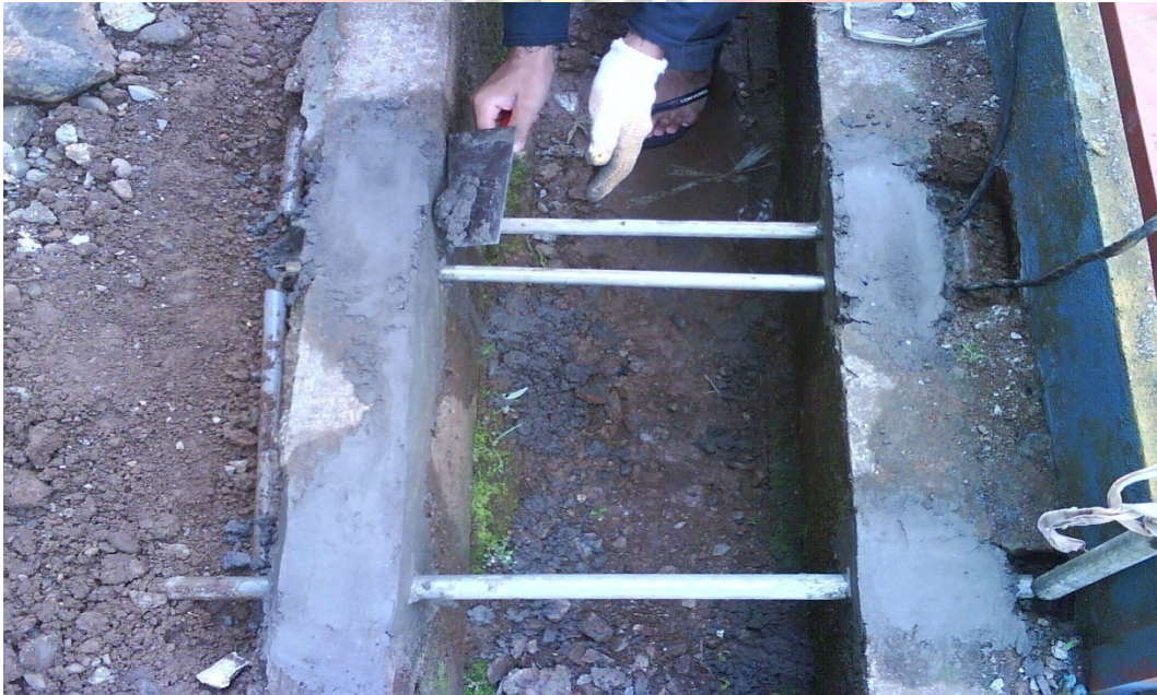
Lampiran 20. Proses pengecoran pipa penghantar
