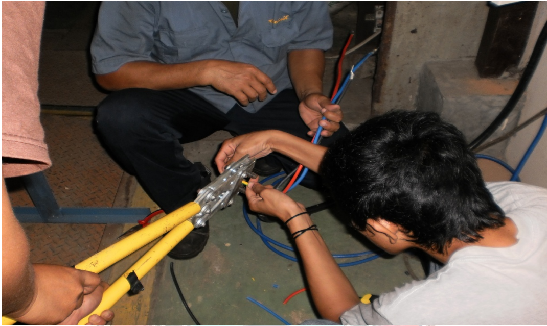
Lampiran 29. Pemasangan Skun Pada Kabel Pentanahan Internal Dibantu Teknisi
