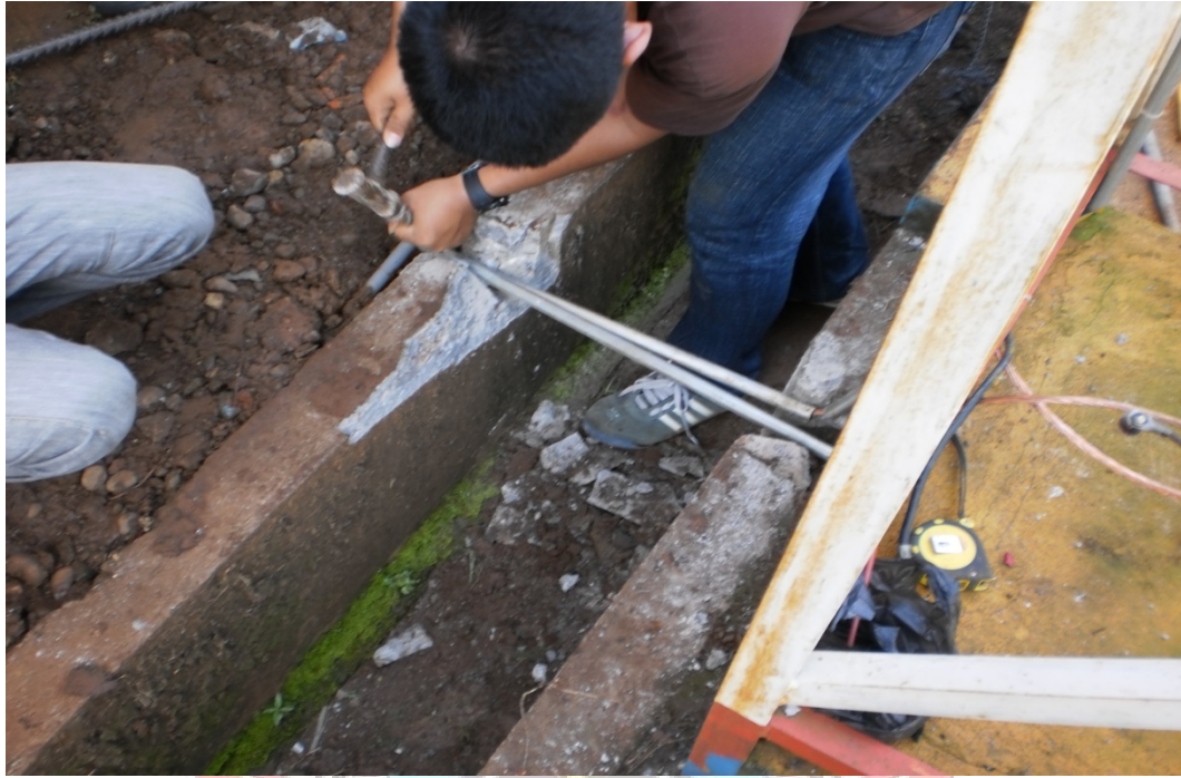
Lampiran 15 Proses Pembuatan Saluran Penghantar Untuk Penangkal Petir Eksternal
