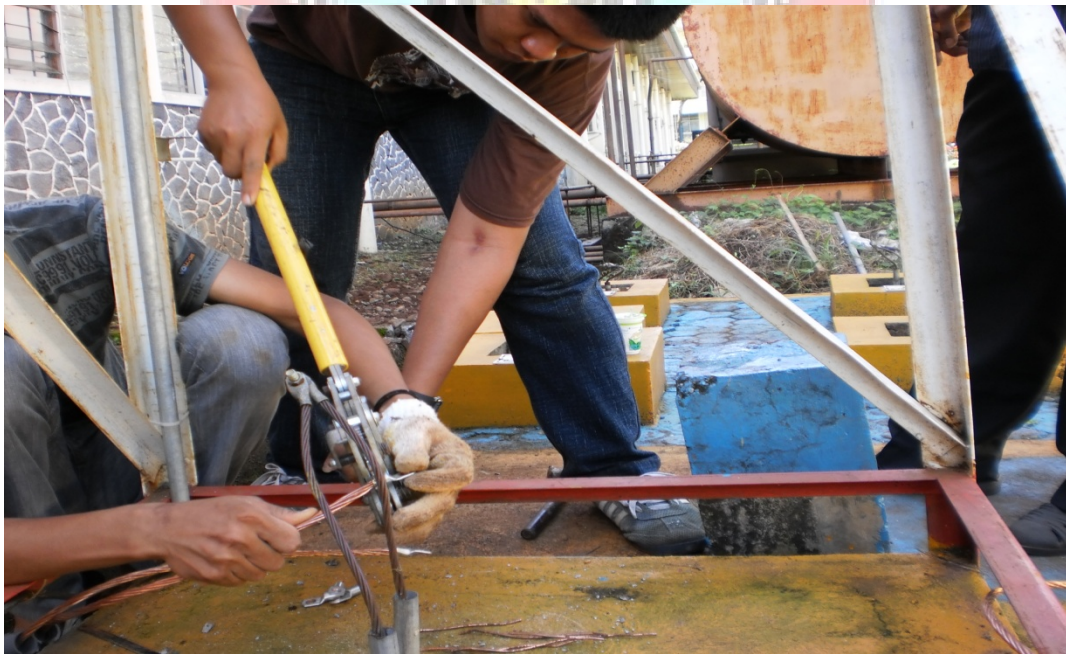
Lampiran 30. Pemasangan Skun Pada Kabel Pentanahan Eksternal
