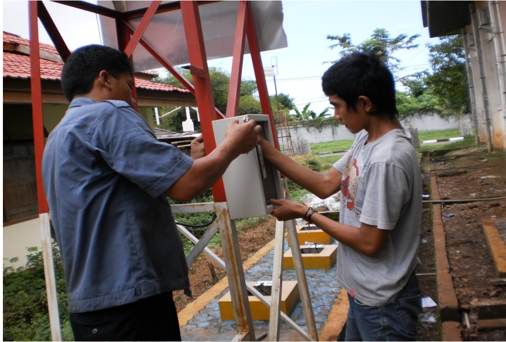
Lampiran 23. Pemasangan Box Panel Laightning Counter dibantu oleh Teknisi
