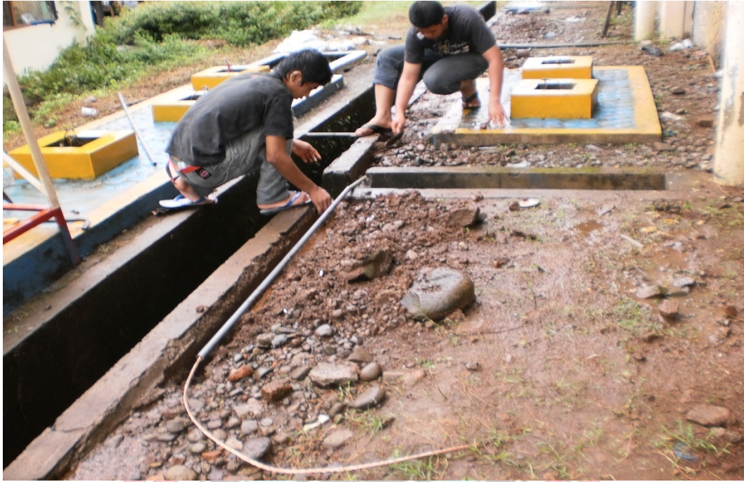
Lampiran 13. Proses penimbungan penghantar Pentanahan kedalam Tanah
