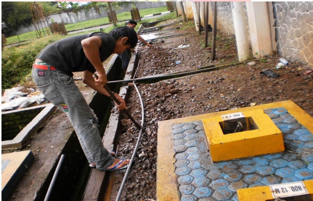
Lampiran 12. Pipa Penghantar dirapikan sebelum ditanam ditanah
