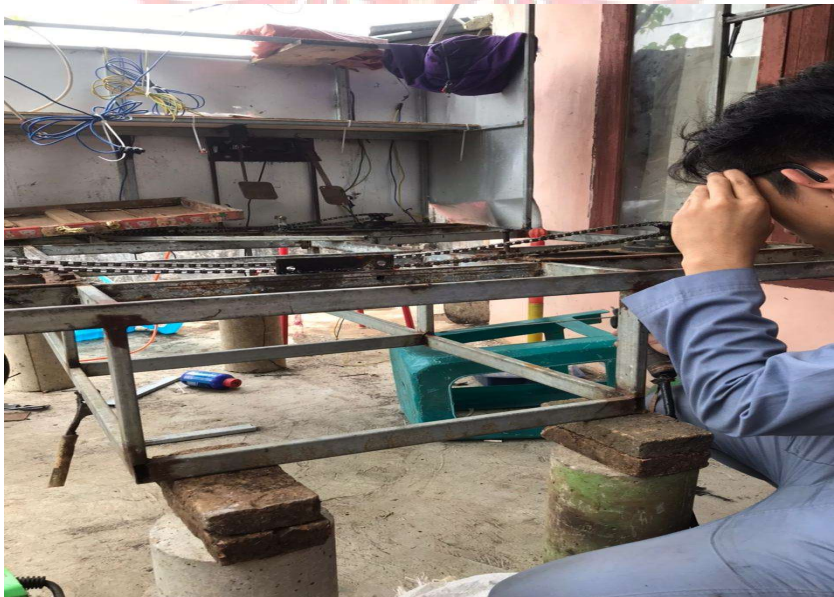
Lampiran 2 Gambar Proses Pengelasan Stand Baterai
