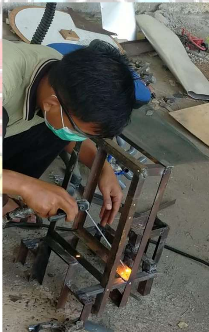
Gambar 2. Pengelasan Dudukan Turbin dan Generator DC
