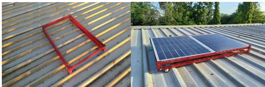
Gambar 4. 2 Rangka Panel Surya Sebelum dan Sesudah Terpasang
