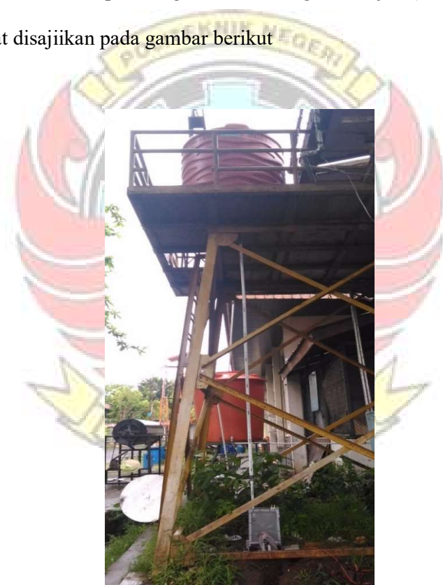
Gambar 4. 3 Menara Tangki Air
