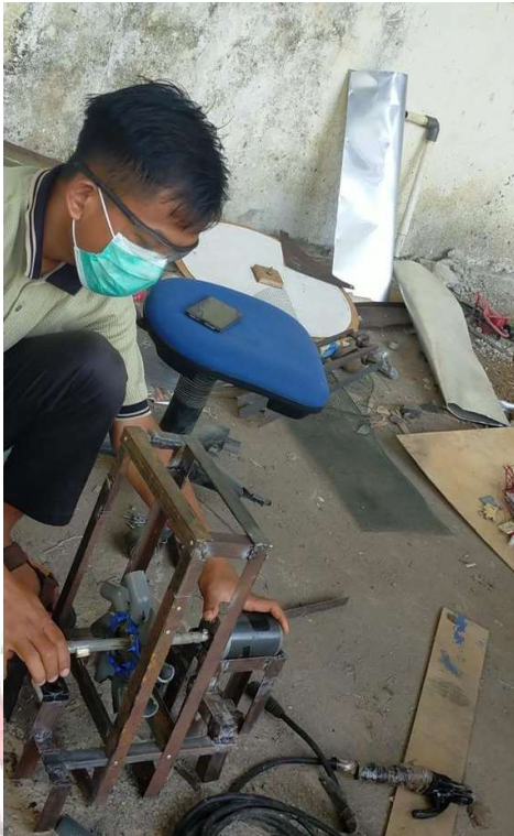
Gambar 3. Perakitan Dudukan Turbin dan Generator DC
