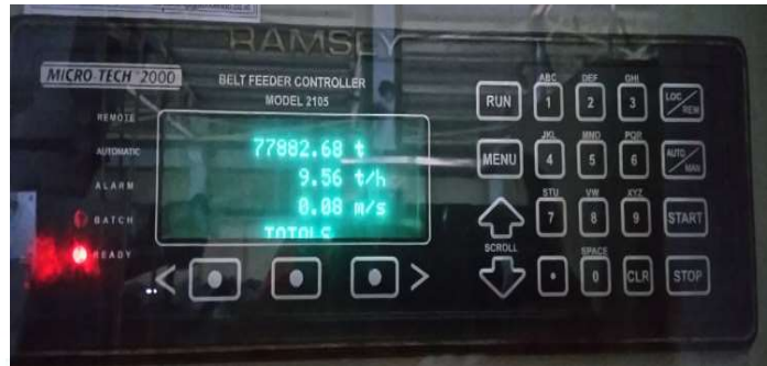
Gambar 2.22 Tampilan Dari Load Cell . Sumber : PLTU Barru.
