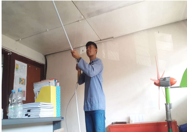
Proses pemasangan instalasi
