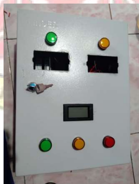
Gambar C. 3 Pemasangan Alat Ukur
