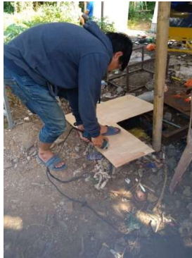
Gambar C. 1 Pemotongan Tripleks untuk penyanggah
