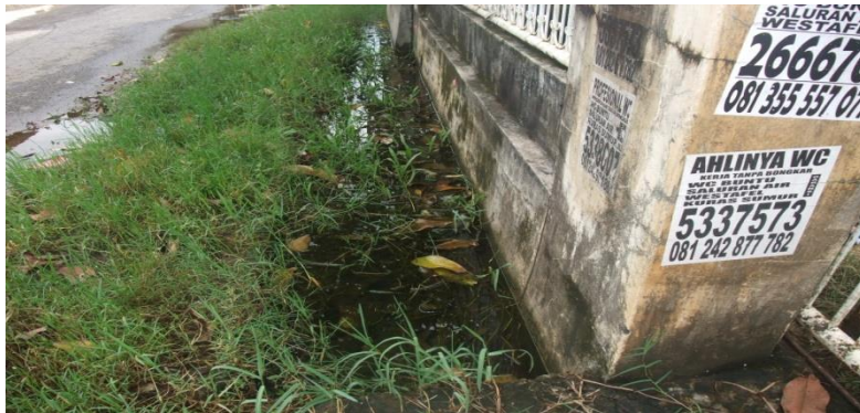
Kondisi drainase blok AA
