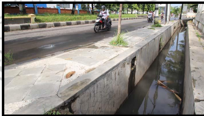
Gambar 2.5 : Drainase Saluran Terbuka
