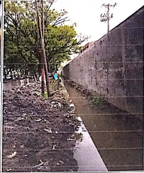
Keadaan Eksisting Saluran
