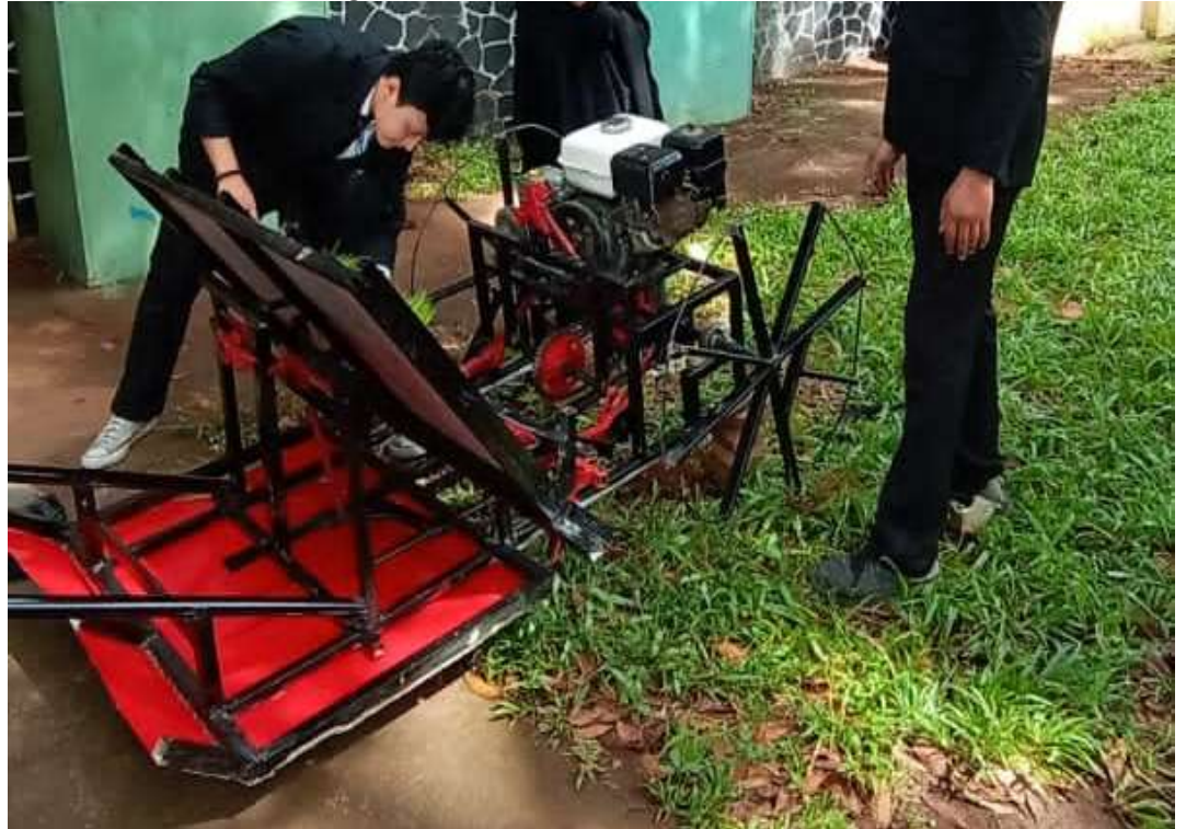
Pemasangan Mesin dan reduser
