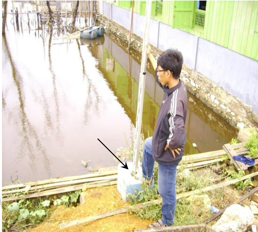
Gambar 29. Pengikatan peilschal terhadap BM
