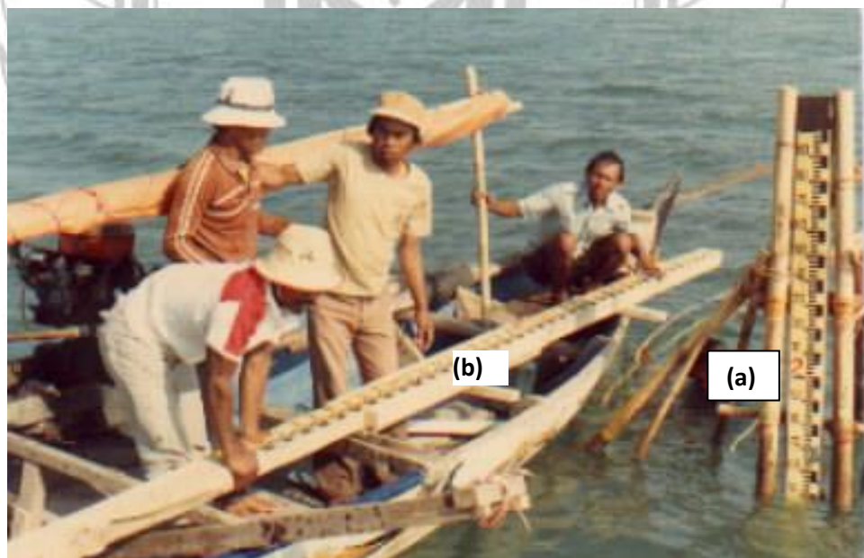
Gambar 10. Pemasangan papan duga
