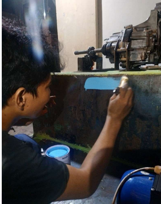
Gambar 3.20 Pengecatan pada rangka transmisi
