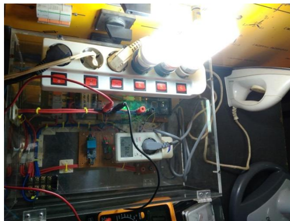
Gambar 5.13 Pengujian Beban Lampu
