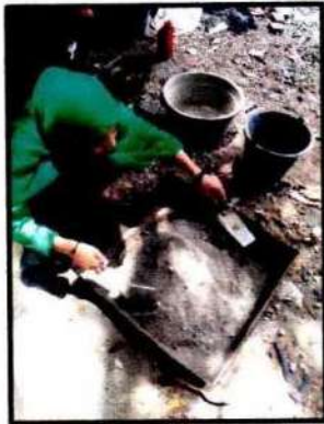
Proses Pembuatan Dasar Saluran Beton dan Kerikil
