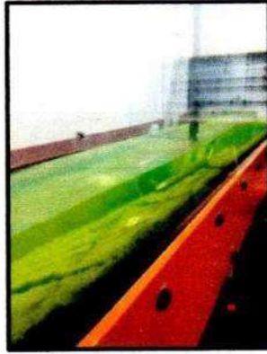
Dasar Saluran Beton
