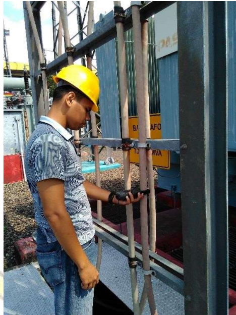
Gambar 27. Pengukuran arus netral transformator
