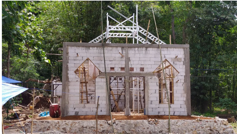
Gambar 4. Kondisi pembangunan mushalla saat ini
