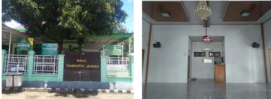
Gambar 5. Kondisi fisik bangunan masjid Raudhatul Jannah (tampak luar dan tampak dalam)
