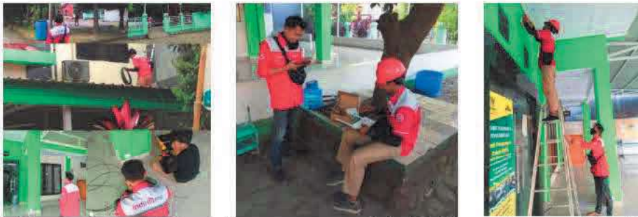
Gambar 6. Mitra Industri melaksanakan pemasangan Kabel Indihome ke target lokasi Mitra PKM.
