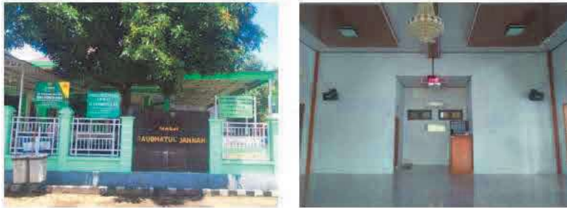
Gambar 4. Kondisi fisik bangunan masjid Raudhatul Jannah (tampak luar dan tampak dalam).
