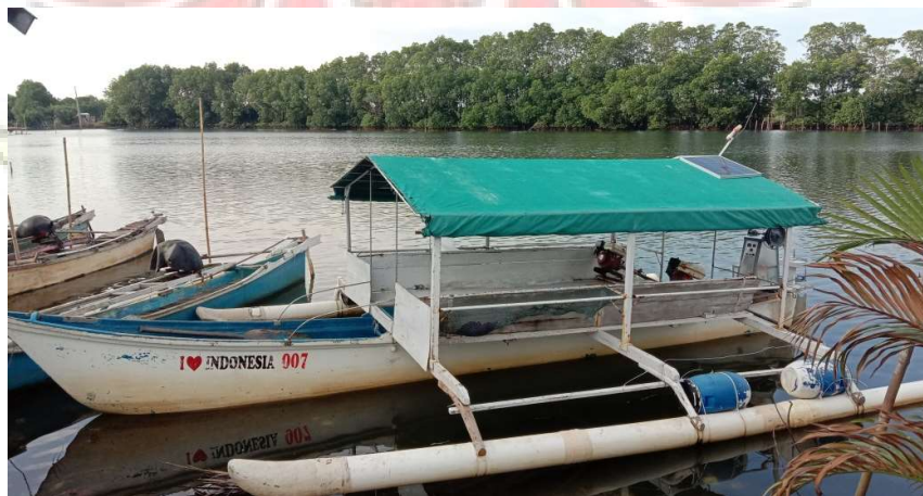
Gambar 4.1 PLTS pada Perahu Nelayan
