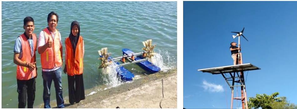
Gambar 1. Konstruksi mekanik aerator, panel surya dan turbin angin.
