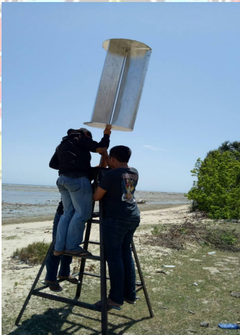
Perakitan Turbin, Poros, dan Rangka
