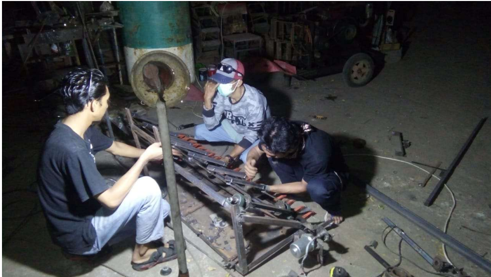
Pemasangan Penyangga padi di Belt penghantar
