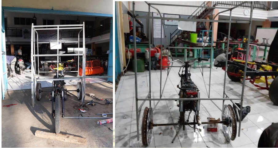
Gambar 4. 21 Pemasangan rangka bodi pada chasis sepeda motor
