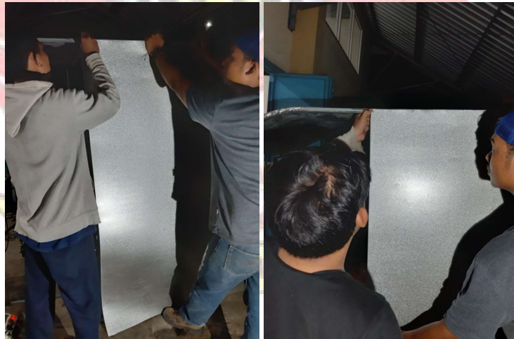
Gambar 4. 22 Pemasangan plat seng pada rangka bodi
