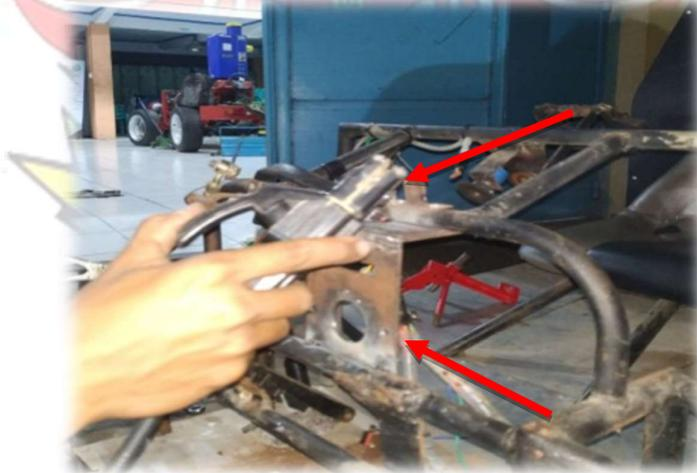
b. Proses pengelesan dudukan master rem ke rangka mobil
