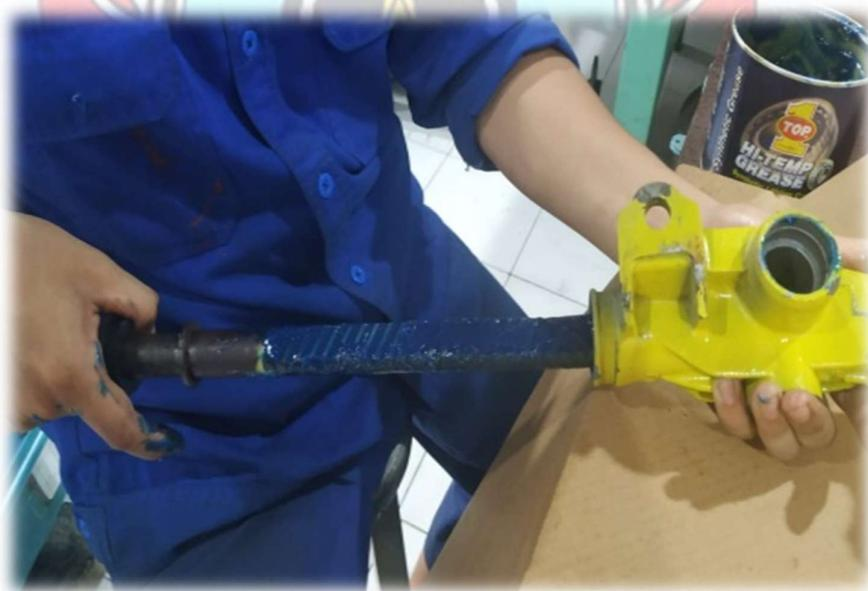
c. Pemasangan batang *rack* ke *rack housing*
