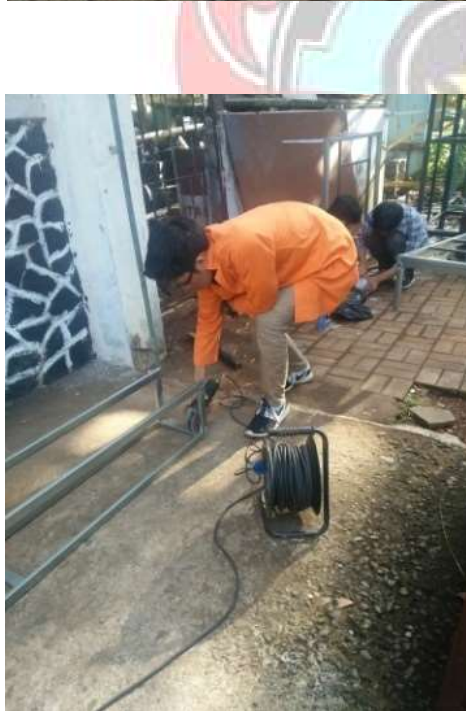
Proses pembuatan rangka waste water pit
