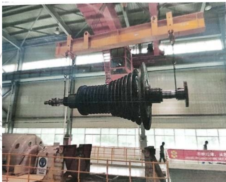
Gambar 2. 21 Turbin Uap 30 MW PLTU Mamuju
