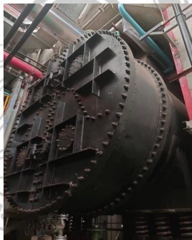
Gambar 2. 26 Kondensor (sumber: PLTU Mamuju 2x25 MW)
