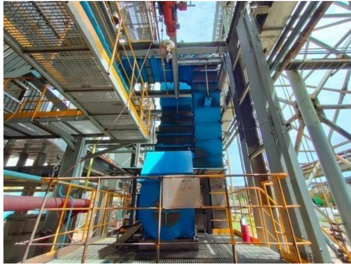
Gambar 2. 16 Primary Air Fan (PAF) PLTU Mamuju 2x25 MW
