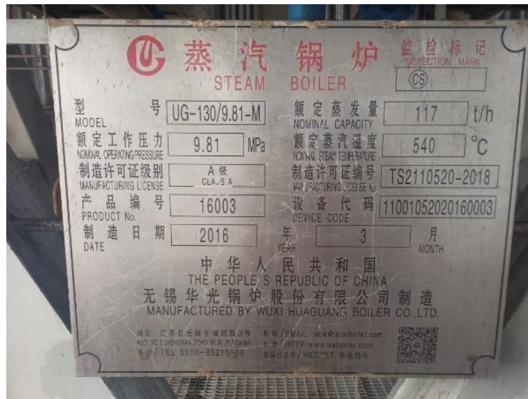
Gambar 2. 7 Spesifikasi Boiler CFB PLTU Mamuju (sumber: PLTU Mamuju 2x25 MW)
