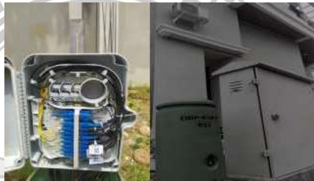
Gambar 2. 17 ODP Pedestal
