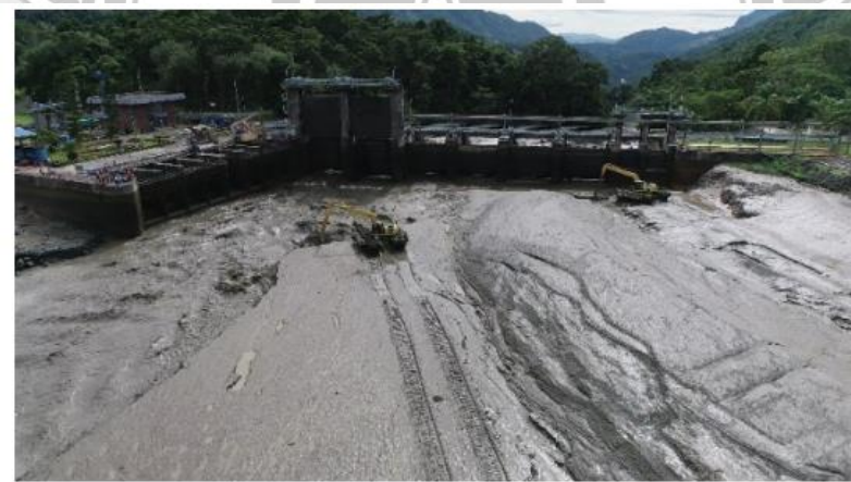
Gambar 4. 28 Kondisi Hulu Bendungan saat Pengosongan Waduk
