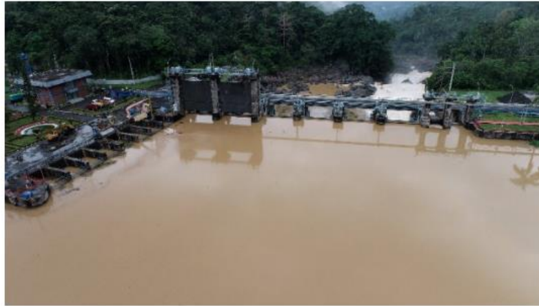
Gambar 4. 27 Kondisi Hulu Bendungan
