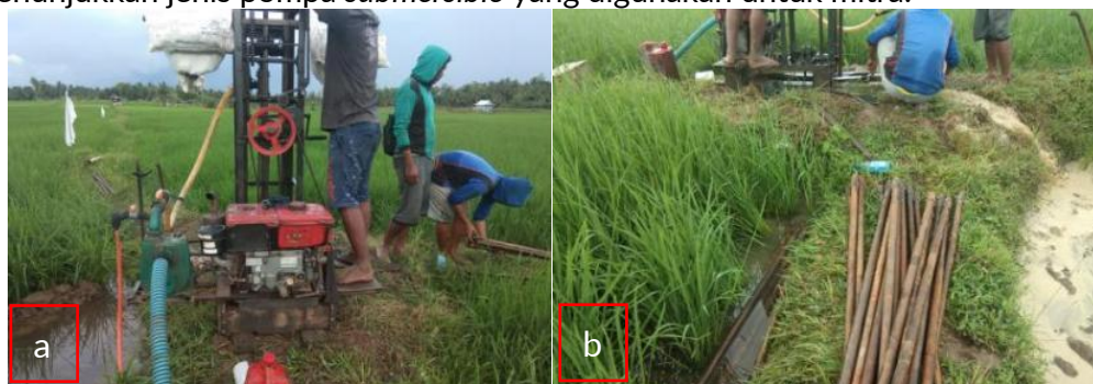
Gambar 5. Proses Pengerjaan Sumur Bor untuk Mitra
