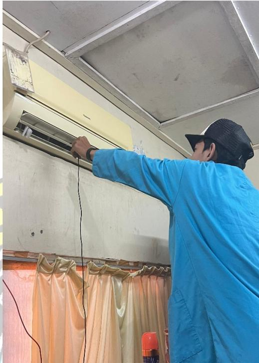
Gambar 7. Proses Pemasangan Sensor Suhu DS18B20 pada AC
