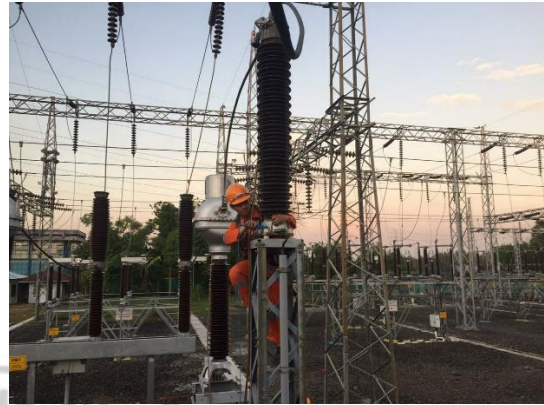
Lampiran 10. Dokumentasi Kegiatan HAR Bay Transformator #1 GI Tello 150 kV
