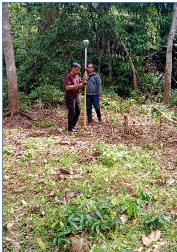
Gambar 9. Stake out titik-titik posisi bangunan di lokasi pembangunan masjid
