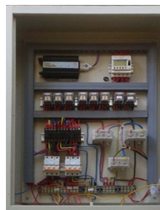
Gambar 6. Rangkaian pengawatan dalam panel ATS/AMF
